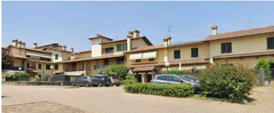
1 - facciata su strada
